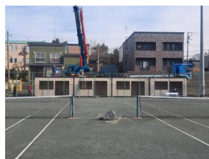
部室設置の様子
