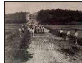
あんぱん道路工事中
